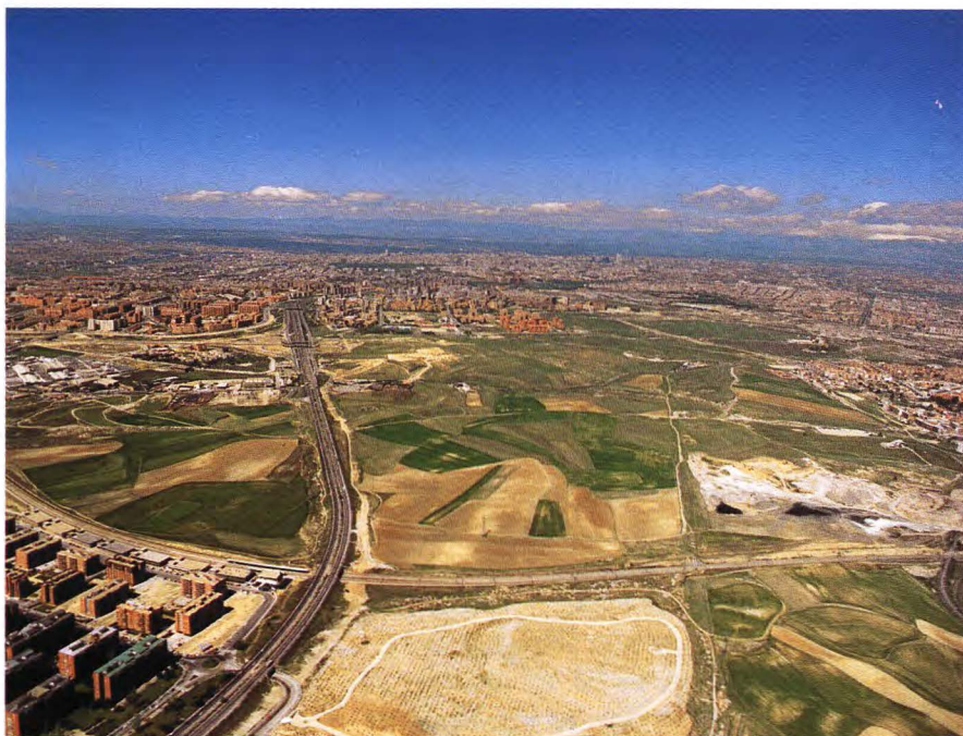
Vista aérea del ámbito de actuación antes del inicio de las obras (1988). En primer término la N-III Madrid-Valencia, al fondo los barrios de Palomeras y Moratalaz.
